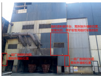
图1 原反应塔拆除的区域划分
