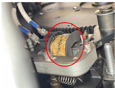
图4 故障合闸线圈
