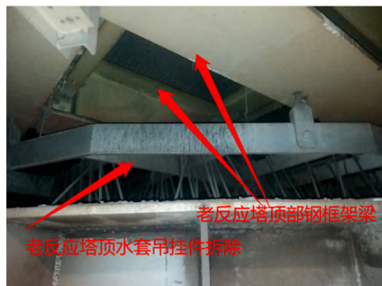
图2 原反应塔水套拆除与钢框架梁
