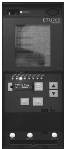
图1 过流脱扣器状态
